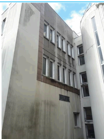
Matériaux : ZPSO-002 Prélèvement : P009; P010; P011; P012 Description : Enduit extérieur (projeté, lissé ou taloché) Localisation : Parties extérieures Résultat : Présence d'amiante
