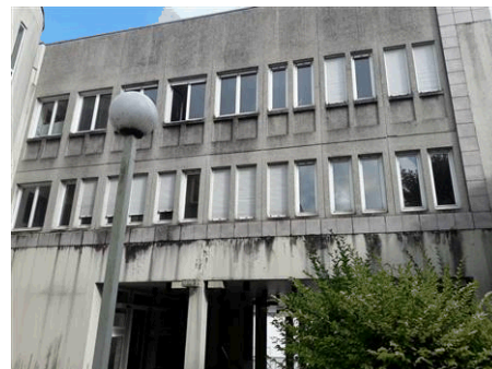
Matériaux : ZPSO-002 Prélèvement : P009; P010; P011; P012 Description : Enduit extérieur (projeté, lissé ou taloché) Localisation : Parties extérieures Résultat : Présence d'amiante
